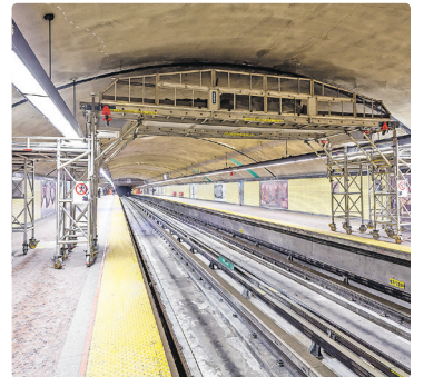
Un exemple d'échafaudage quai à quai
