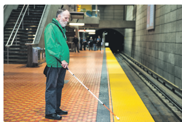
Des tuiles d'avertissement tactiles ont été installées dans l'ensemble des stations.
