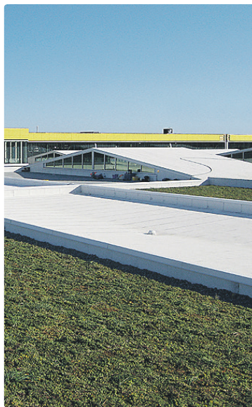
Une vue du toit vert du Centre de transport Stinson
