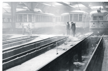
L'intérieur du dépôt Mont-Royal en 1959.
