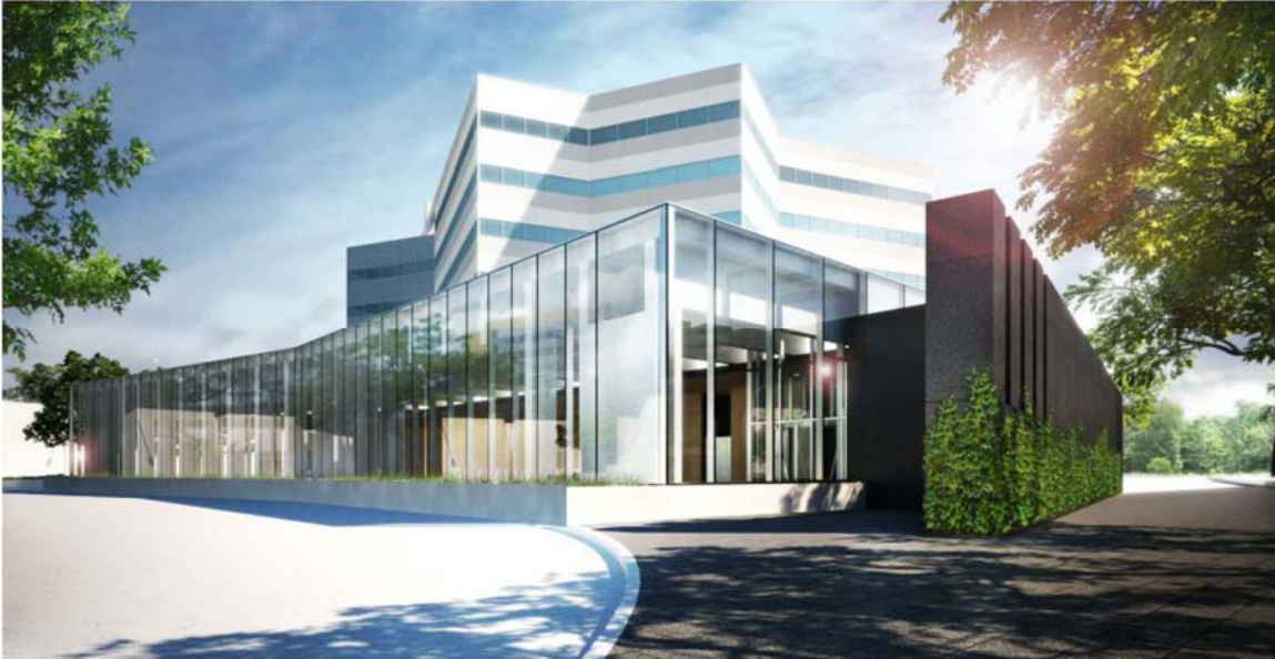
Figure 4 – Vue projetée vers le nord-est et mur antichoc
