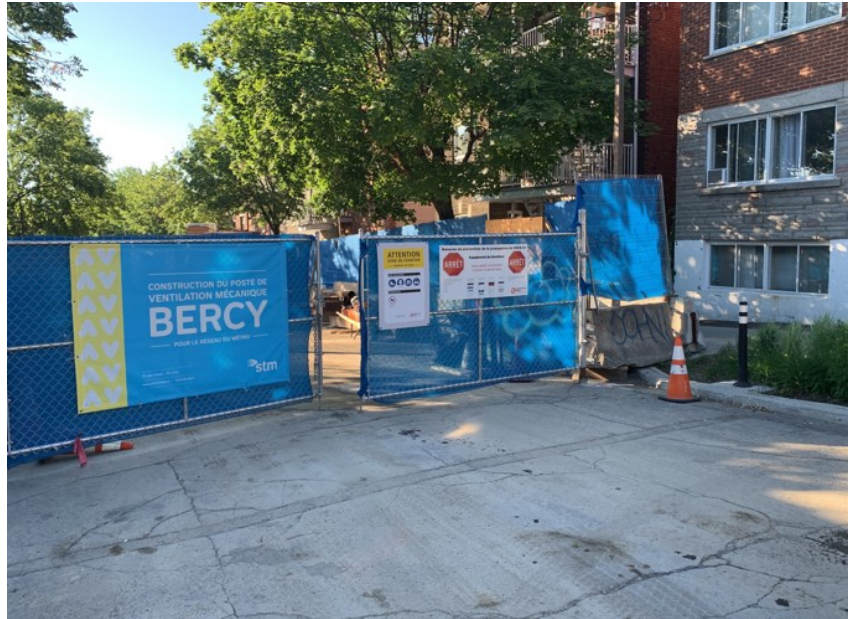
Mise en place des clôtures de chantier.
