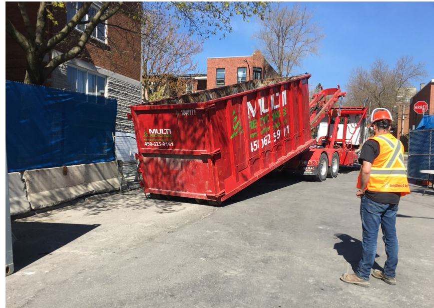
Livraison d'équipements de chantier.
