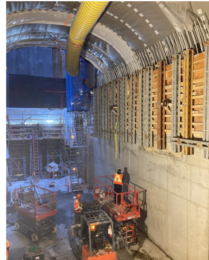
Armature et coffrage.
