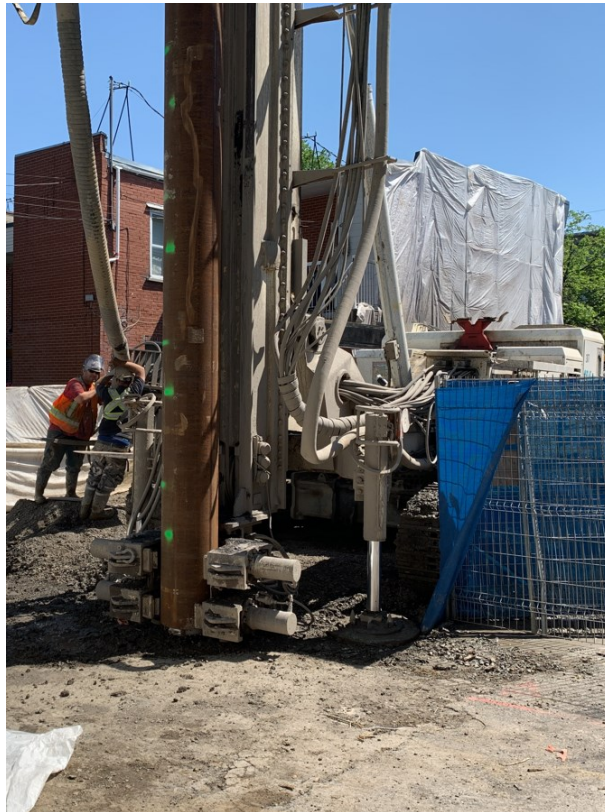
Installation de pieux forés au périmètre de l'excavation.
