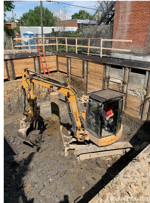
Excavation du mort terrain. Installation de la paroi berlinoise.
