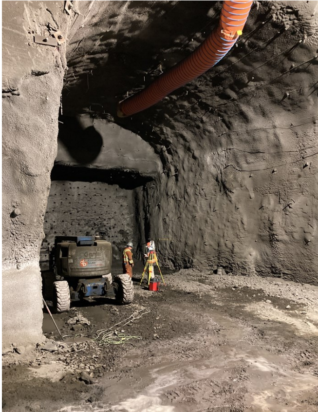
Consolidation du roc et béton projeté.
