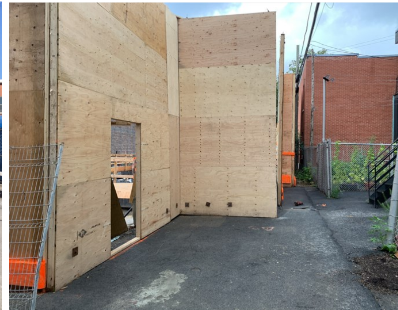
Installation des écrans antibruit (si requis).
