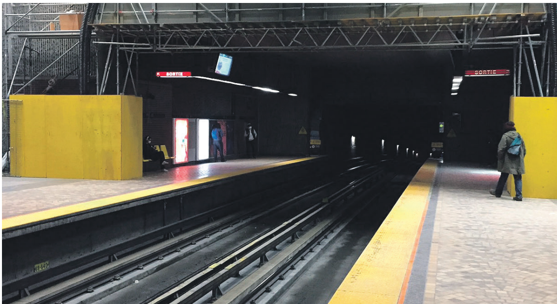
Des échafaudages quai à quai à la station Pie-IX
