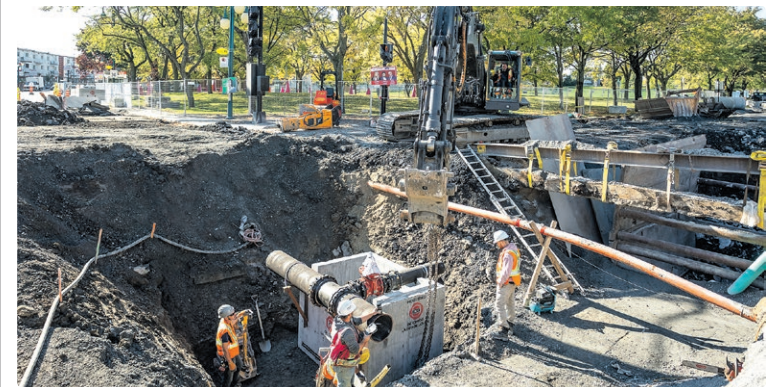
Parmi les travaux réalisés au cours des derniers mois, au coin Jean-Talon et Lacordaire, une chambre de vannes secondaire est installée. Elle permettra d'isoler le réseau d'aqueduc et minimisera l'impact sur les résidents du quartier en cas de futures interventions par la Ville.
