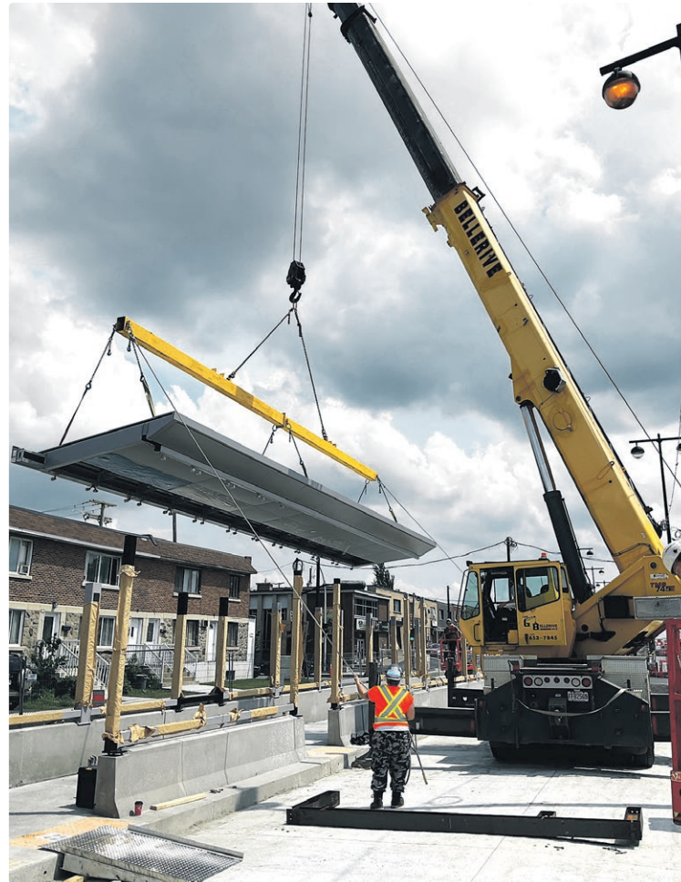
Un abri du SRB présentement en construction.
