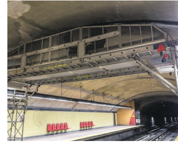
Un exemple d'échafaudage temporaire dans une station.
