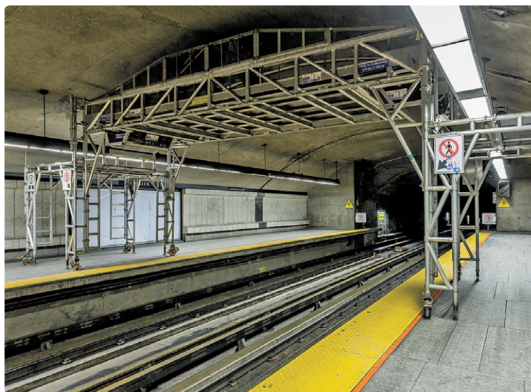
Des échafaudages quai à quai.
