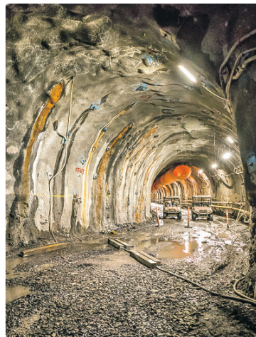
Un aperçu de la construction de notre garage pour les voitures AZUR à la station Côte-Vertu.
