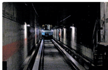
La voie d'essai est longue de 575 mètres. Elle permet de vérifier dans des conditions réelles d'exploitation les mesures de performance sur les trains dont on vient de faire l'entretien à l'atelier.
