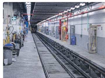
La voie de lavage est l'endroit où l'on amène les trains pour les laver à l'intérieur et à l'extérieur.
