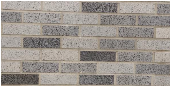
Maçonnerie de briques existantes et nouvelles
