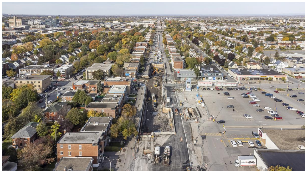
Chantier du SRB Pie-IX – intersection Jean-Talon/Pie-IX
