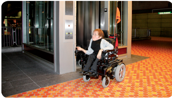
En septembre 2009 étaient mis en service des ascenseurs dans trois stations de la ligne Orange.
