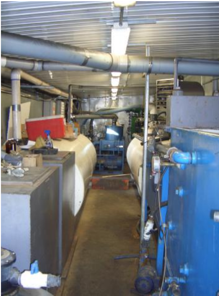
Système d'extraction sous vide, St-Henri
