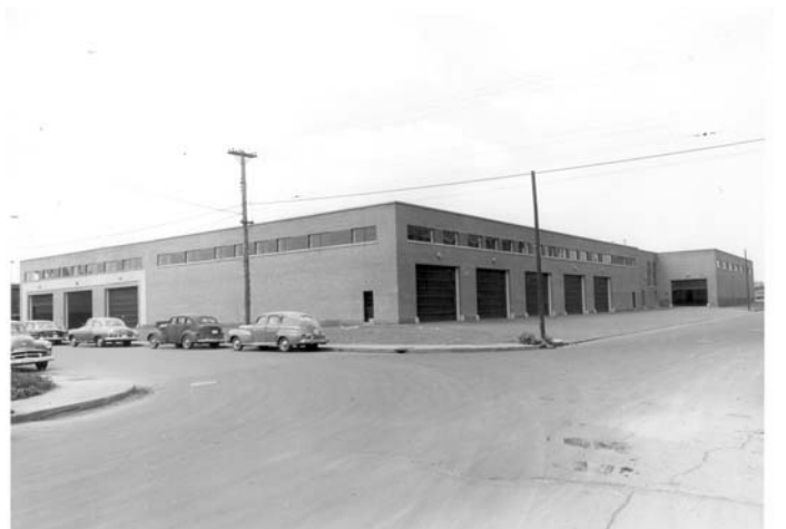
On peut imaginer l'odeur de béton frais qui devait régner à l'intérieur du garage Frontenac au moment de la prise de cette photo, à la fin des travaux de construction de la partie sud.
