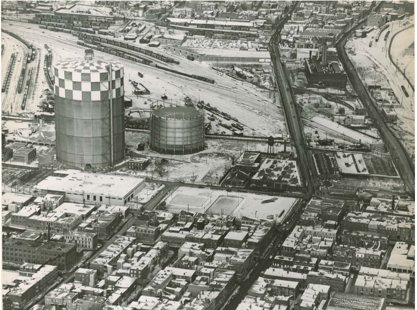
Vue aérienne en 1956. À gauche, face à l'imposant réservoir de la compagnie du gaz, la première partie du garage d'autobus Frontenac est en construction. À droite, les remises de tramways en voie de démolition et plus loin vers l'est, la centrale d'électricité.
