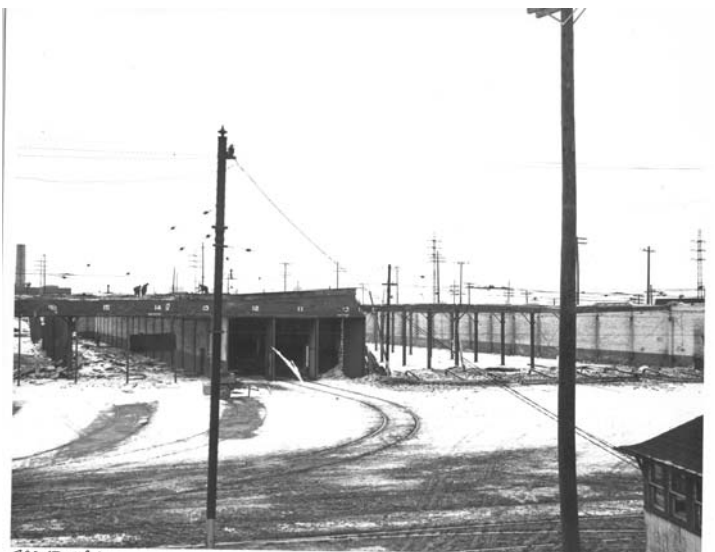
Les remises lors de leur démolition en 1956, vues depuis le bureau divisionnaire.
