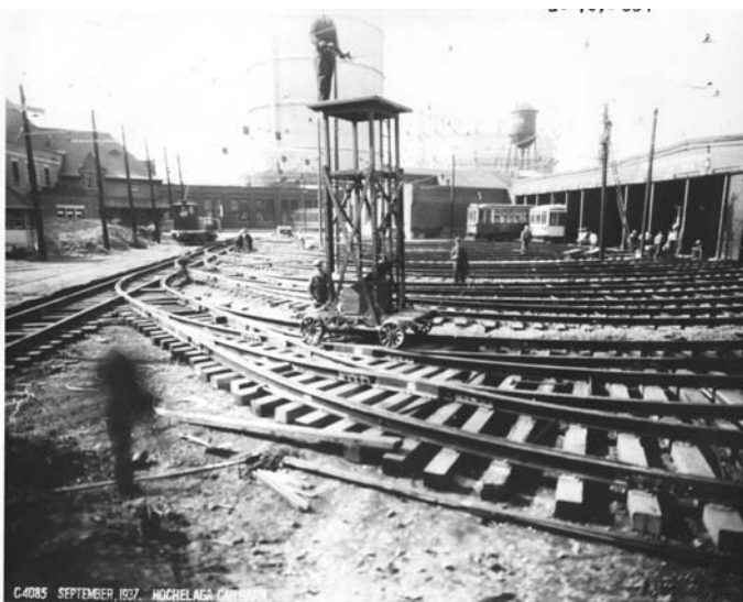
Les remises d'Hochelaga en septembre 1937, lors de travaux de réfection des voies de tramways.
