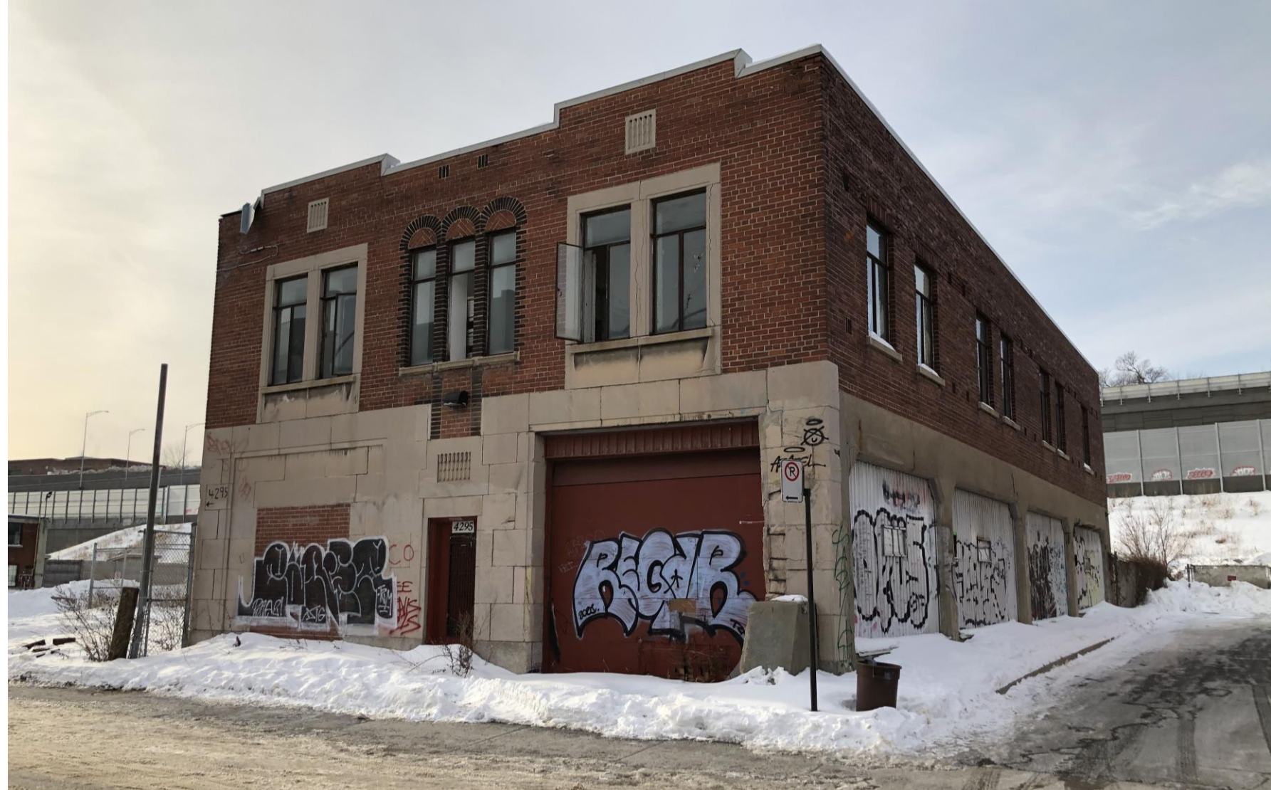
Le bâtiment à démolir est situé au 4295, rue de Richelieu à Montréal. Source : STM, février 2021
