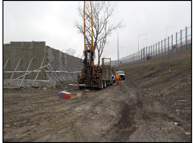
Vue de l'emplacement du forage 20F13.
