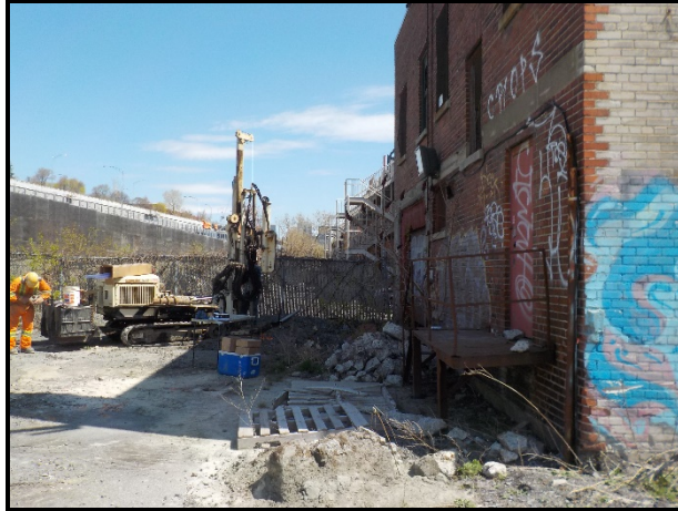
Vue de l'emplacement du forage 20F10.
