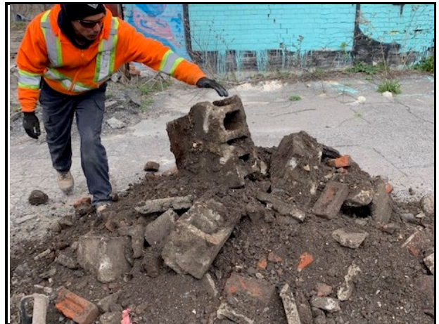
Vue des matières résiduelles rencontrées dans la tranchée d'exploration 20TE04.
