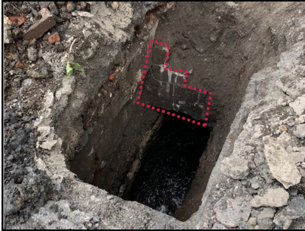
Vue de la tranchée d'exploration 20TE05 et du mur de fondation.
