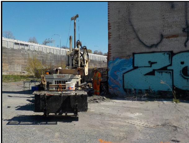
Vue de l'emplacement du forage 20F08.
