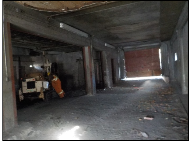
Vue de l'emplacement du forage 20F02.
