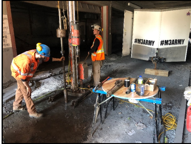
Vue de l'emplacement du forage 20F01.
