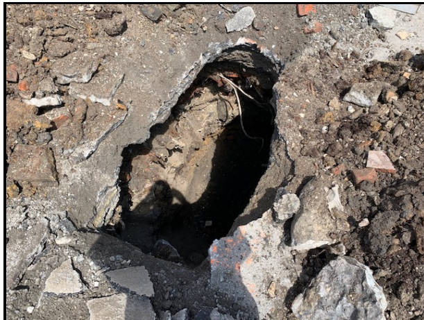
Vue de la tranchée d'exploration 20TE04.
