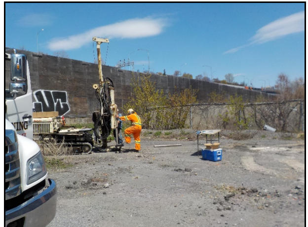
Vue de l'emplacement du forage 20F09.
