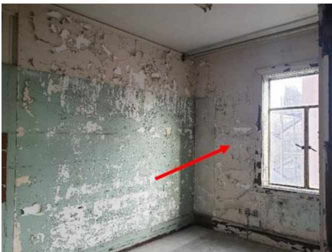
FIGURE 35 Autre espace de bureaux se situant à l'étage de l'immeuble à l'étude. Source : STM.
