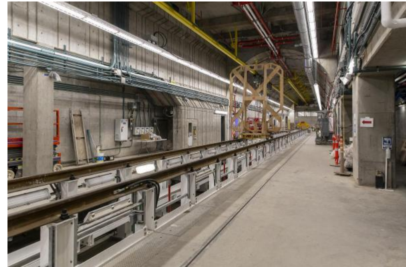
Atelier d'entretien du garage Côte-Vertu
