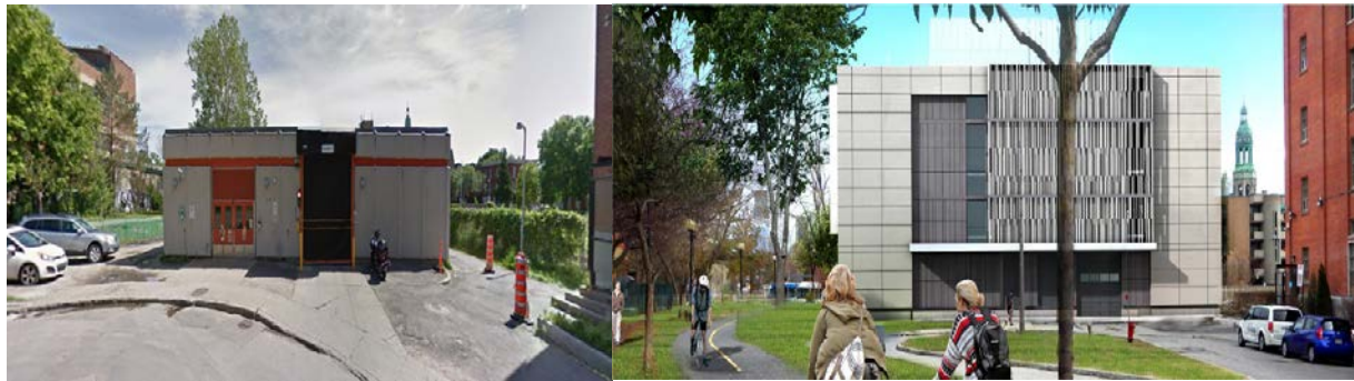
Figure 4 : Le poste actuel (vu de l'avenue Lionel-Groulx) et le nouveau poste
