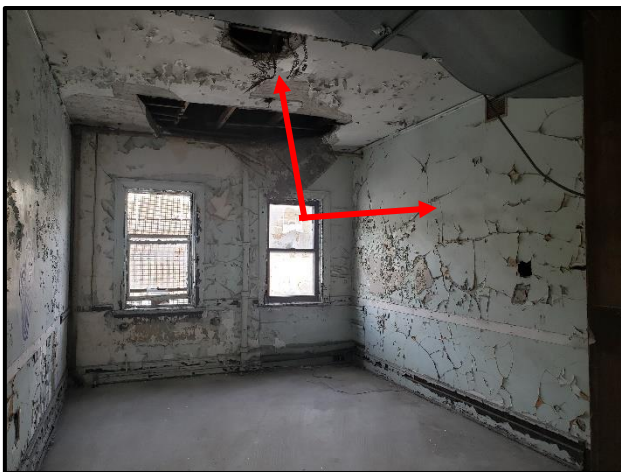
2 e étage | Groupe 02 Ciment plâtre lisse sur treillis métallique Absence d'amiante
