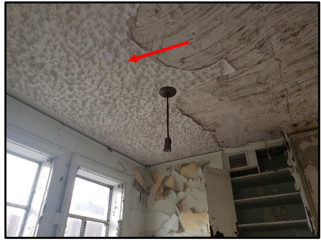
2 e étage | Groupe 01 Plâtre texturé sur ciment plâtre lisse Absence d'amiante
