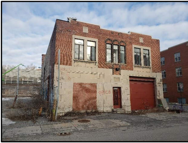
Vue extérieure du bâtiment
